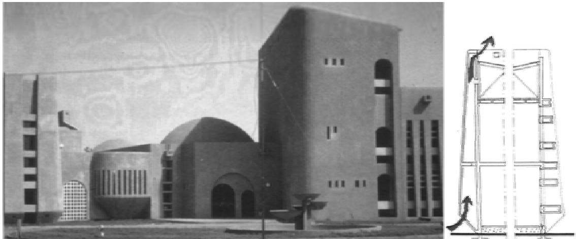
Figura 4.6 - Arch. Mester de Parajd: edifici del complesso del tribunale di Niamey (Nigeria).
