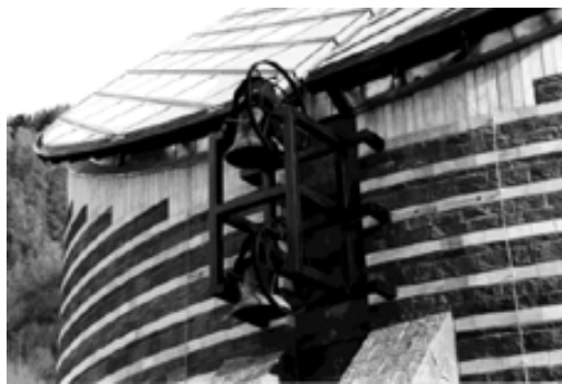
Particolare della copertura inclinata della chiesa di Mogno (CH).
